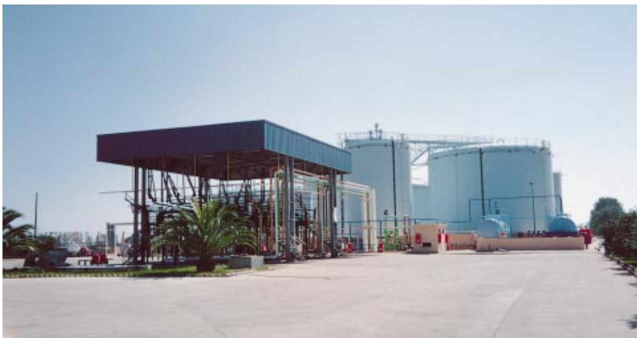
Stockage d'hydrocarbures (Photo EDF)
