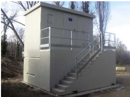
Poste préfabriqué avec rehausse
