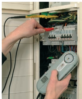
Contrôle d'isolement sur tableau domestique entre phase et terre avec le DT-500. (Réf. DT-500).
