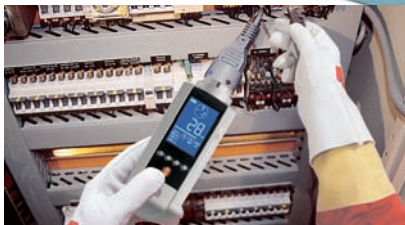
Contrôle des différentiels avec le Catex™ NG DT-170 muni du cordon pour intervention sur tableau (Réf. M-952271).
