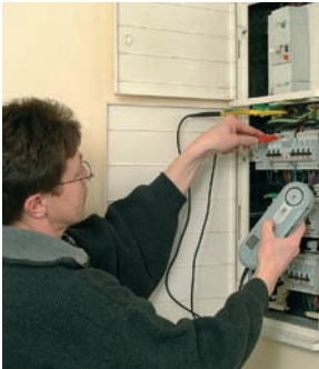
Contrôle d'isolement sur tableau entre phase/neutre et terre avec le DT-500 (Réf. DT-500).
